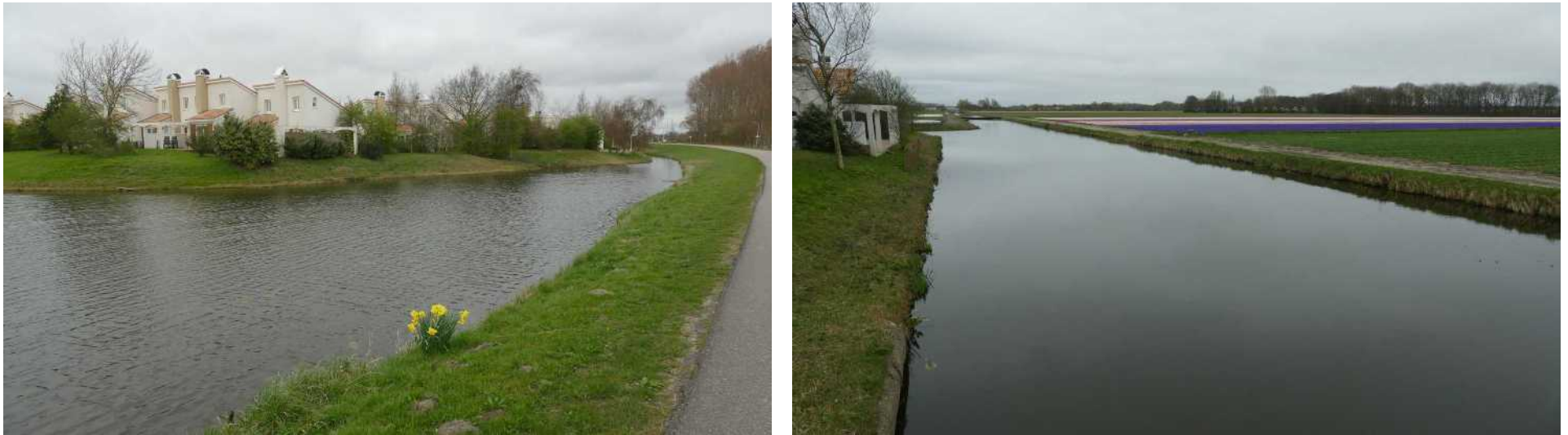
Figuur 55 – Open water rond het Duinresort Dunimar in Noordwijk met ruimte voor ecologische oevers.
