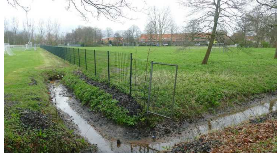
Figuur 56 – Langs de Katwijkseweg in Wassenaar loopt nog een goed functionerende duinrel. Het opschonen kan de functie voor de waterfauna versterken.
