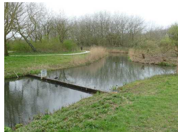
Figuur 3 - bij dit voorbeeld in Noordwijk zorgt een dammetje dat schoon kwelwater uit het duin gescheiden blijft van het boezemwater
