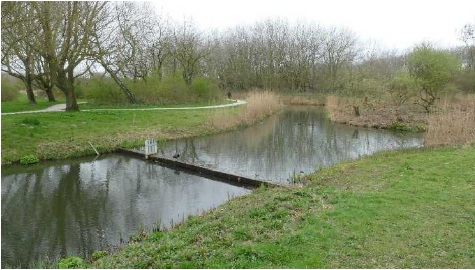
Figuur 68 – Een voorbeeld van een damwand die schoon kwelwater uit de duinen gescheiden houdt van het boezemwater (nabij de Campingweg in Katwijk).
